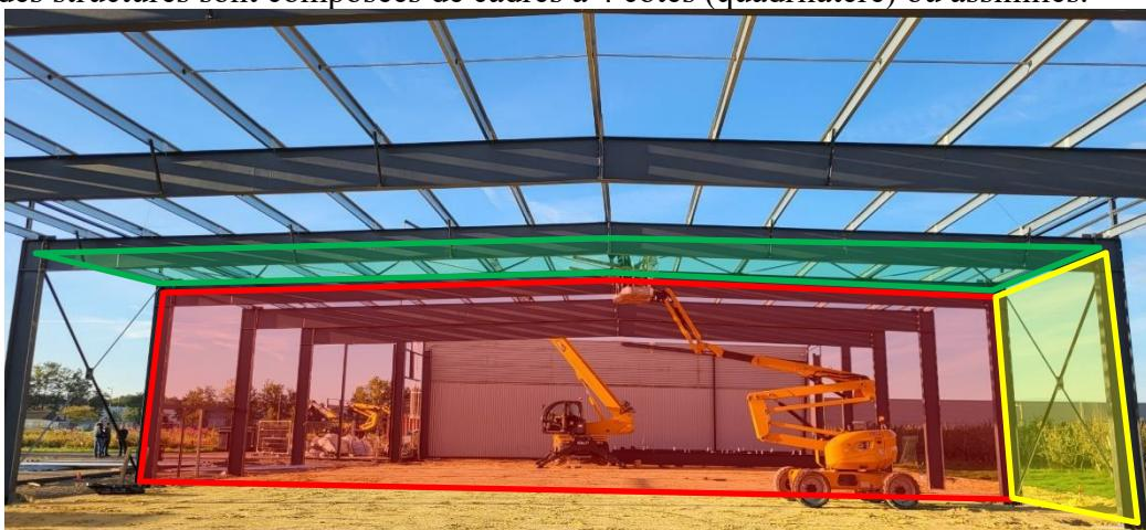
La problématique d'assurer la stabilité de ces cadres consiste à assurer une déformation acceptable sous les différentes actions (charges permanentes, d'exploitation, neige, vent, séisme...) qu'ils vont subir.
