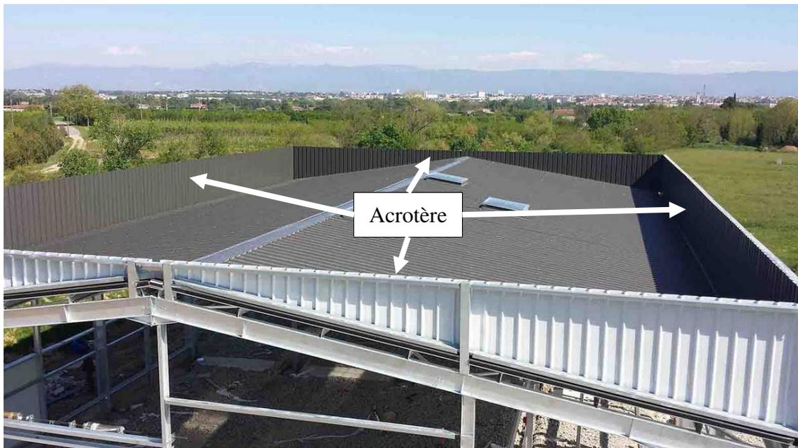
Le terme n'est pas réservé à la charpente métallique, pour les structures en béton, on parle également d'acrotère.
